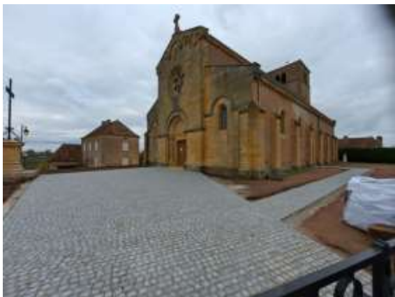
Aménagement du parvis de l'église
